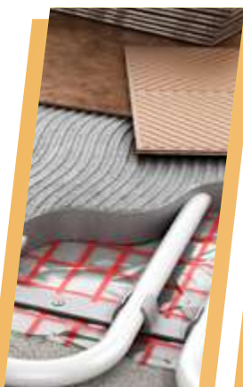
Облицовка полов с подогревом
